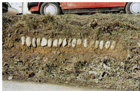
Figure 8 Un potentiel aménagement routier d'époque antique découvert à Aime. Cliché : A. Canal.
