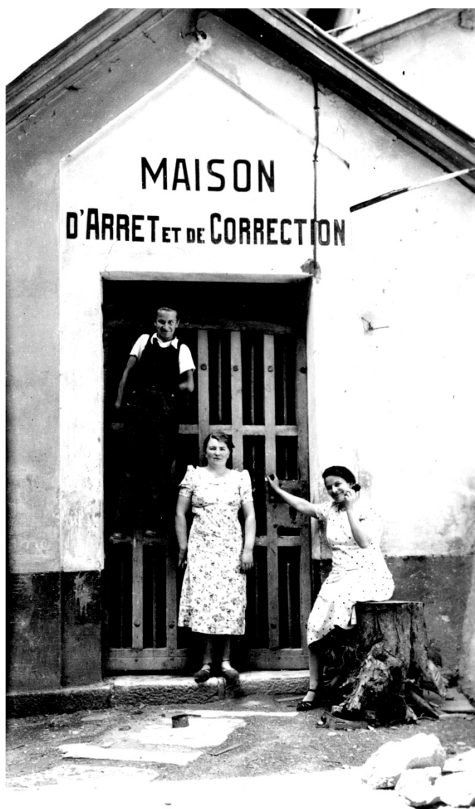
Un rare document de l'entrée de la prison, juste avant sa démolition. (photo aimablement communiquée par la famille Rigotti )
