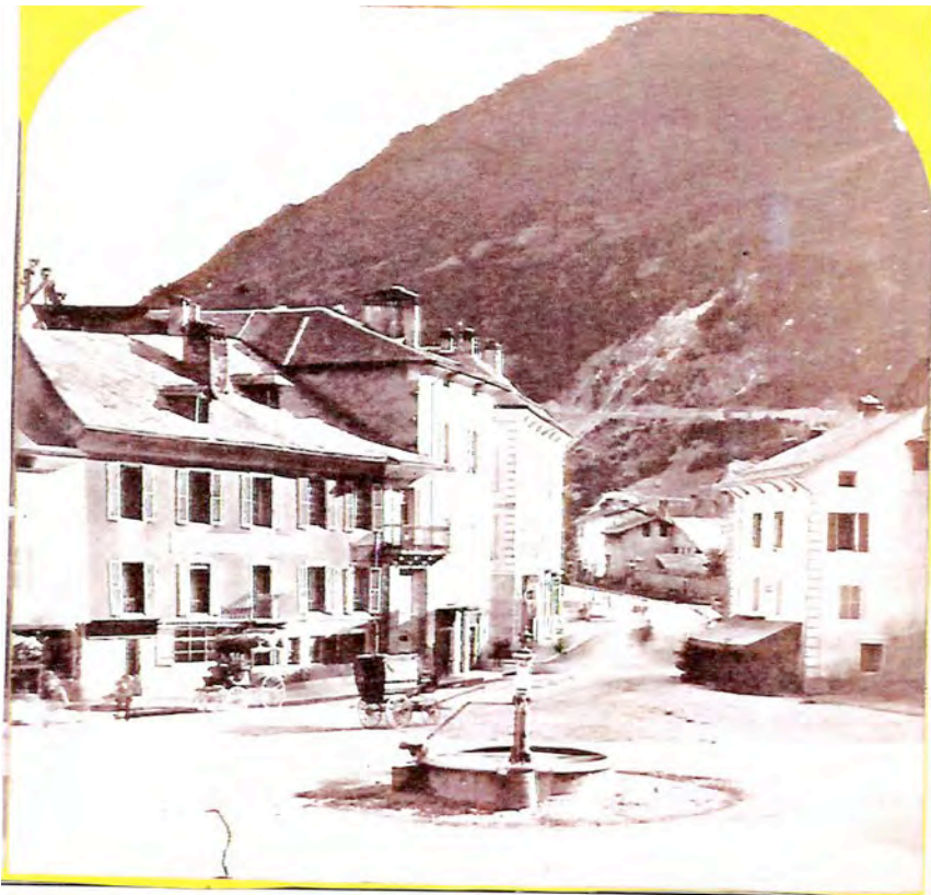
Ancien pré commun et hôtel Bertoli. Les travaux du square n'ont pas commencé. Photo : 1893, environ.
